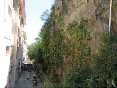
Talude rochoso com quedas de blocos
