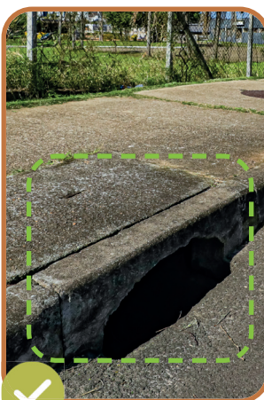
Boca de lobo junto à faixa de serviço e meio-fio
