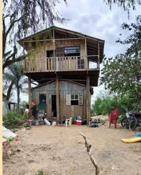
Casa improvisada sobre pilotes elevados, acima da cota das inundações recorrentes.
