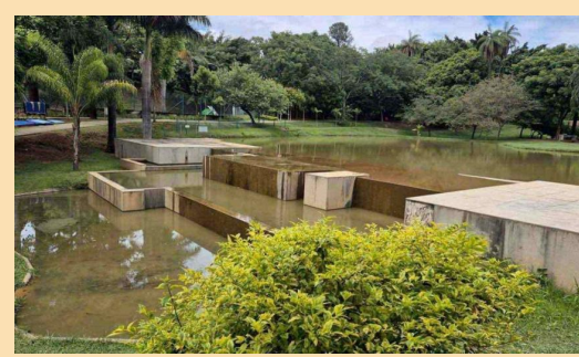
Exemplo de bacia de retenção, Belo Horizonte/MG. Crédito: Jair Amaral/EM/D.A Press.
