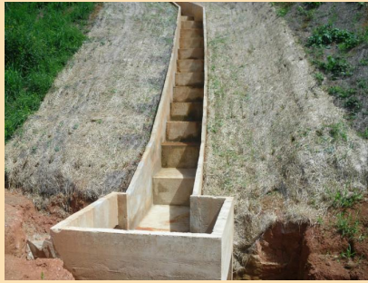
Exemplo de escada de chuva. Fonte: Deflor – Bioengenharia.
