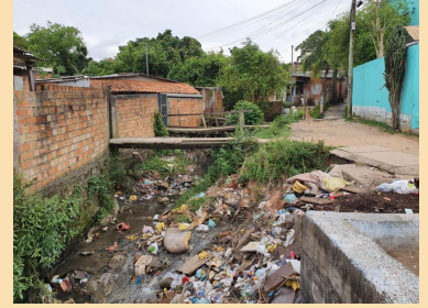
Acúmulo de lixo, acessos improvisados e precários às casas, trecho baixo do Arroio Mem de Sá, Setor 109/01.
