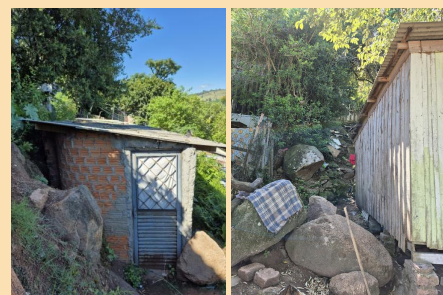
Setores 117/08 (à direita) e 117/13 (à esquerda): casas em áreas íngremes, cortes abruptos no terreno e existência de blocos e fragmentos de rochas.
