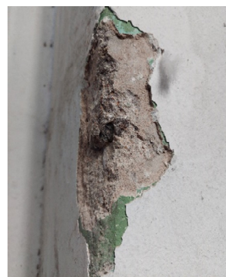
Imagem 4 – Fechamento dos fundos do pavilhão com desgaste da pintura.
