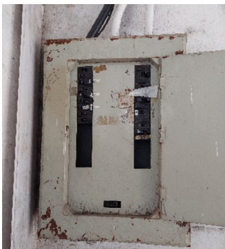
Imagem 38, 39 e 40 – Quadros danificados, sem dispositivos de proteção e fiação exposta.
