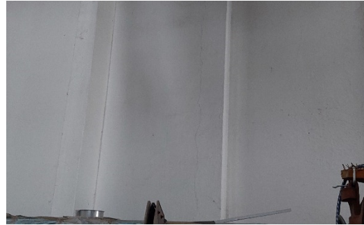
Imagem 15 – Fissura vertical.
