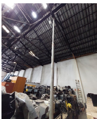
Imagem 26, 27 e 28 – Postes metálicos de sustentação das tesouras, sem fixação na base.
