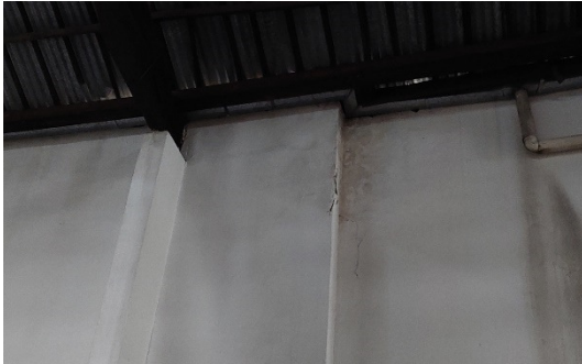
Imagem 14 – Fissura vertical.
