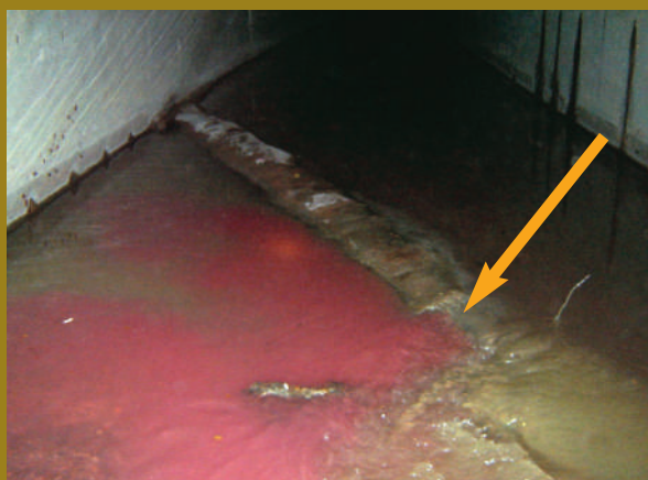
Figura 7. Fotos da tubulação rompida DN 400 de esgoto cloacal na parte interna do canal São Vicente com o corante misturado no efluente cloacal.
