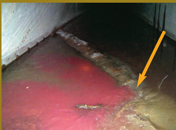
Figura 7. Fotos da tubulação rompida DN 400 de esgoto cloacal na parte interna do canal São Vicente com o corante misturado no efluente cloacal.
