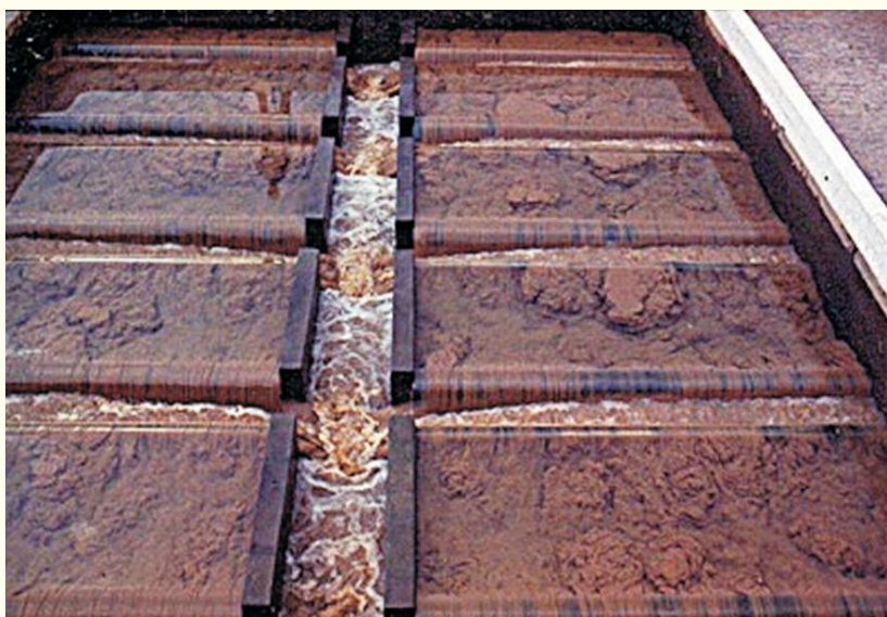
Figura 4: Processo de limpeza das unidades de filtração da ETA JLS.
