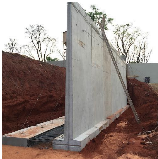
Figura 4-1: Exemplo de muro de Flexão.
