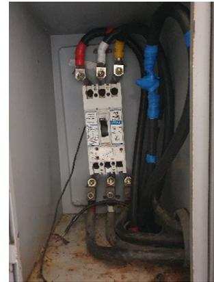
Fig 2: Disjuntor de BT existente
