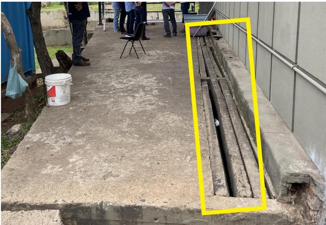
Foto 2 – Acessos para instalação de mangueiras – Poço de sucção EBAP 5
