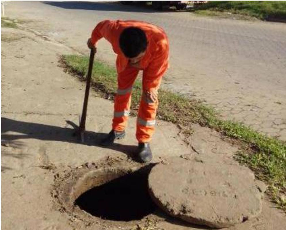
Foto 13: Poço de visita existente na esquina da Av. Voluntários da Pátria interligado diretamente no tanque de acumulação da CB-05.
