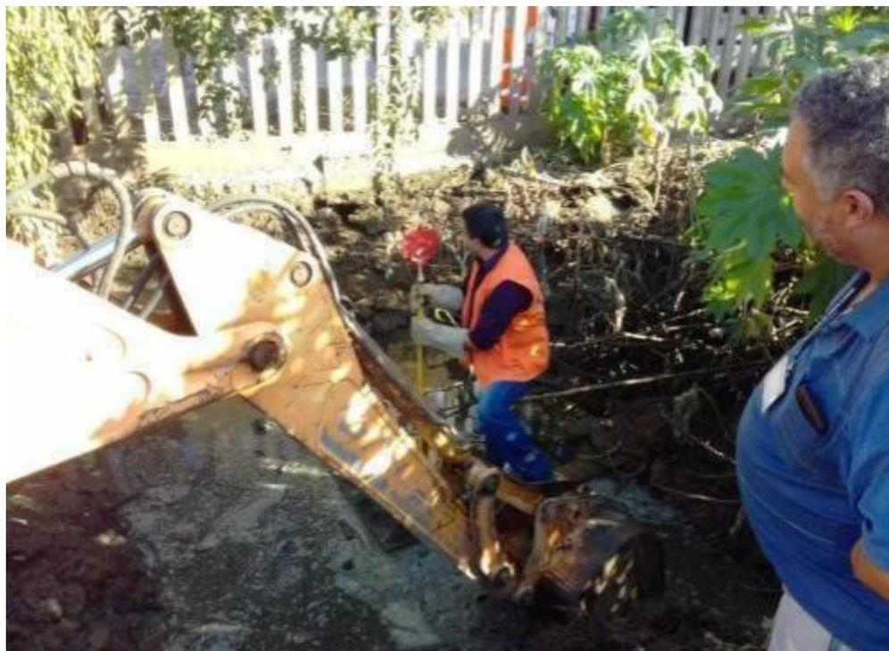
Foto 10: Posto 1 / Antigo depósito das lojas Ponto Frio – Visualização da caixa 2 em área particular. Levantamento topográfico e medição das cotas. Gradis ao fundo por onde o esgoto misto transborda para a Rua Julio Castilhos de Azevedo.
