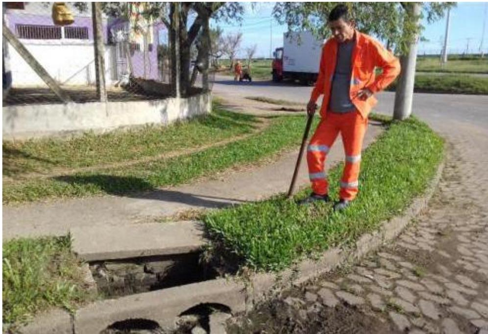
Foto 12: Boca de lobo existente na Rua Julio Castilhos de Azevedo, cota da rua igual a (0,82 m). BL está interligada na rede de microdrenagem, que por sua vez está interligada no tanque de acumulação da CB-05.
