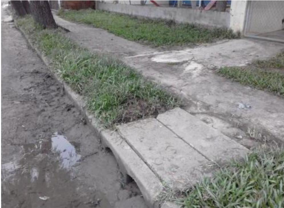
Foto 11: Boca de lobo existente na Rua Julio Castilhos de Azevedo, cota da rua igual a (0,82 m), em frente da creche comunitária. Boca de lobo da microdrenagem responsável pela drenagem do alagamento. Lodo do esgoto misto sedimentado.
