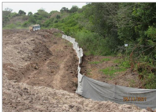
Figura 2-4: Exemplo de barreiras de siltagem instalada para contenção de processos erosivos e assoreamento.
