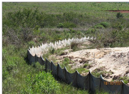
Figura 2-5: Exemplo de barreiras de siltagem instalada para contenção de processos erosivos e assoreamento.
